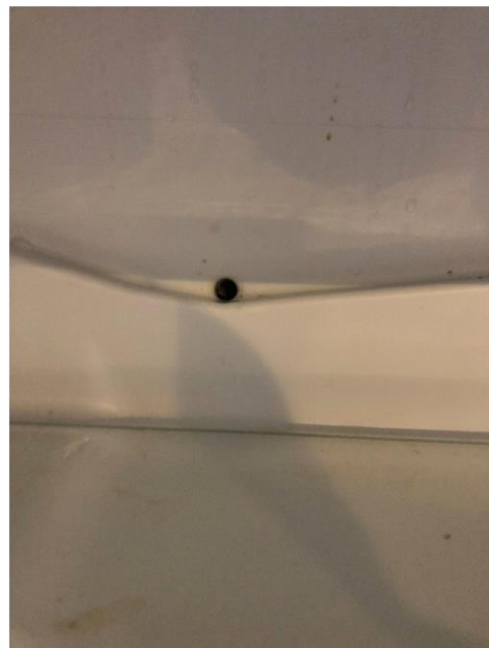
Närbild på öppningen till dräneringskanalen
